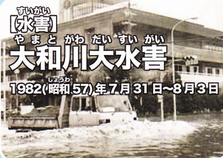
浸水した王寺町役場前を走るトラック
