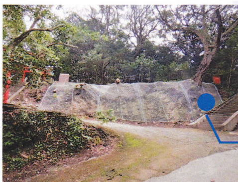
落石防止網工事
