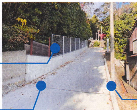
落石防止柵工事
