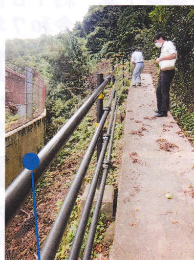
手摺設置工事
